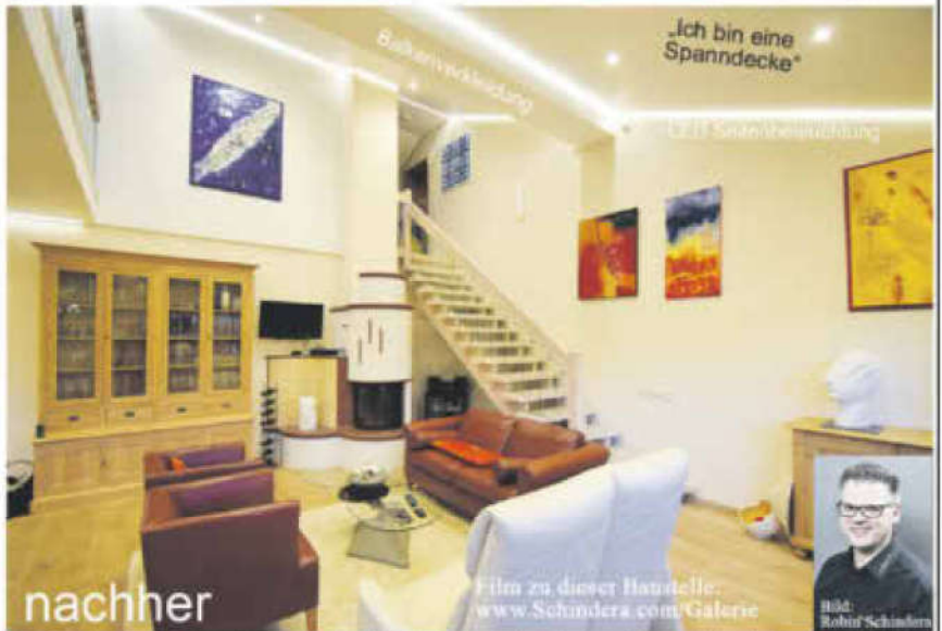
nachher: Moderne, Deutsche Folienspanndecke in Farbe weiß matt, abwaschbar, welche alle Decken und Balken verkleidet. Als Beleuchtung dient eine indirekte LED Beleuchtung, dimmbar!
