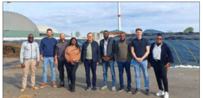
Beantworteten bei der Anlagen-Begehung gerne alle technischen Fragen und freuten sich über den Fachaustausch mit den Gästen aus Otjiwarongo: Die beiden Ingenieure der Ökostrom Saar GmbH Michael Haupenthal (Zweiter von links) und Nico Rosar (Dritter von links).
