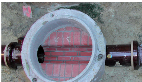
Einbau eines Revisionsschachtes
