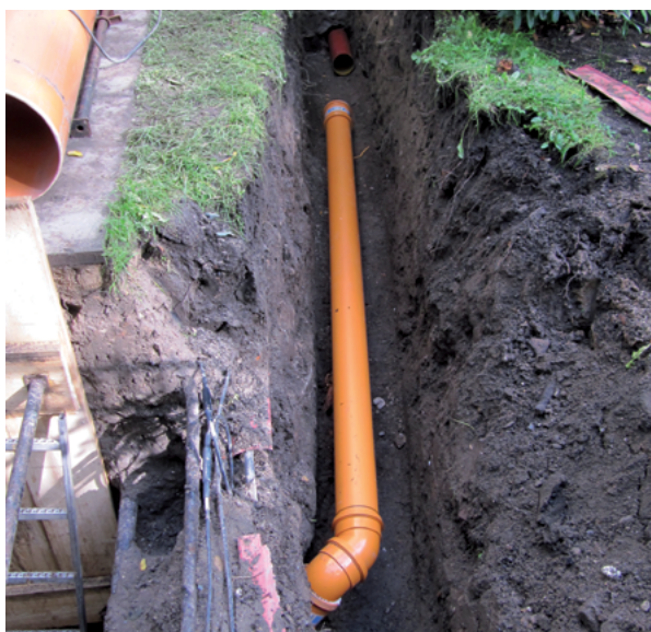
Erneuerung einer Abwasserleitung
