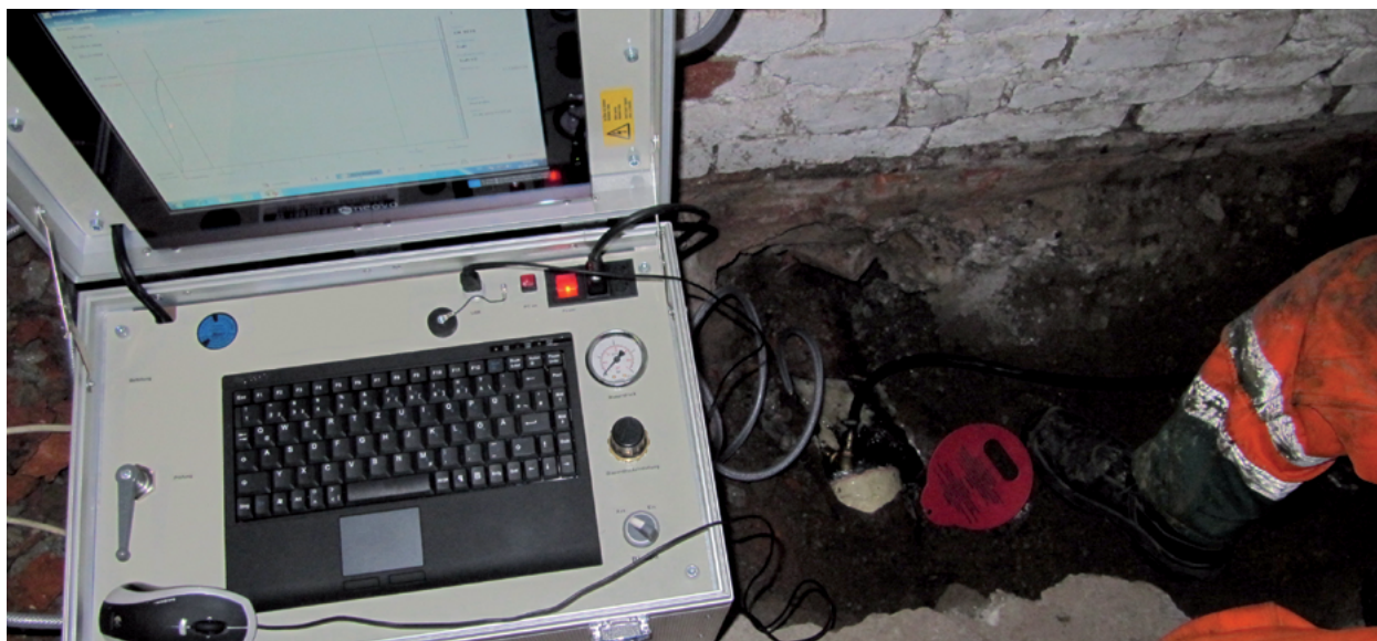
Druckverlustmessung bei der Dichtheitsprüfung mit Luftdruck
