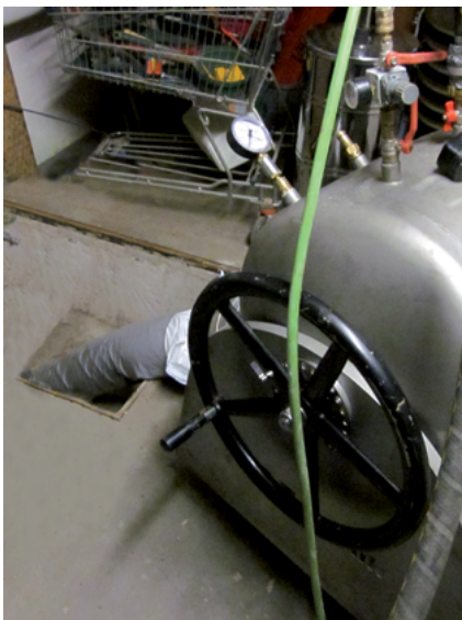
Einbautrommel für das Liningverfahren
