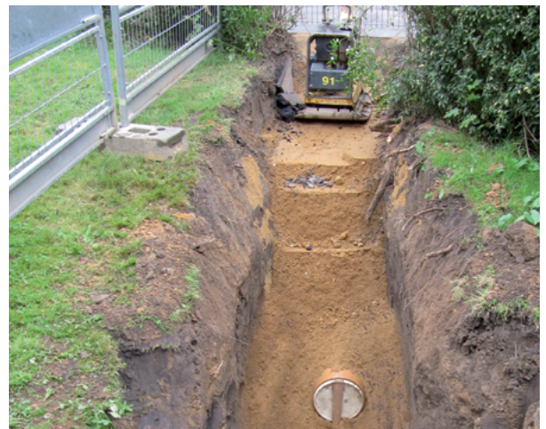
Erneuerung im offenen Graben
