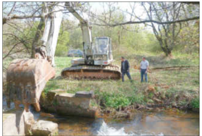
Der Rückbau mit einem Moorbagger ist auch im schwierigen Gelände kein Problem, wovon sich Bürgermeister Harth bei einem Besuch vor Ort überzeugt
