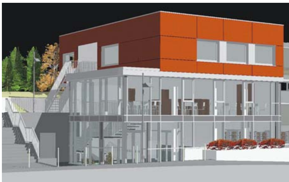
Das Foyer erhält im ersten Bauabschnitt eine großzügige Aluminium-Glaskonstruktion und einen behindertengerechten Aufzug.
