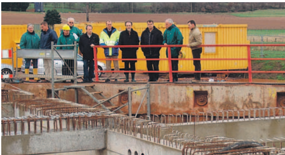
Wolfgang Jakobs vom Planungsbüro Jakobs Gänssle erläutert die bisher ausgeführten Bauarbeiten am großen Regenüberlaufbecken unterhalb des TÜV-Geländes unmittelbar neben dem Losheimer Bach.
